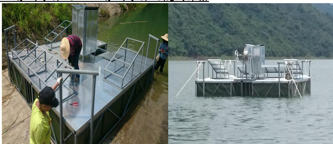
圖摘-4 全新中游 1 站觀測站趕工完成建置並已投入進行觀測作業
